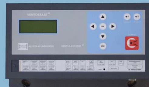
Ventostaat (centrale bediening)
