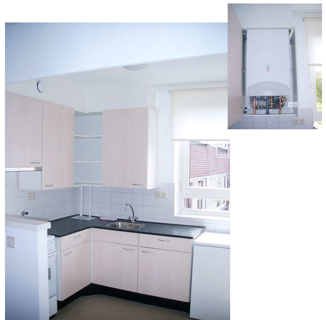
Figuur 16 Keuken als verbeterunit. Cv-ketel weggewerkt in een keukenkastje.
