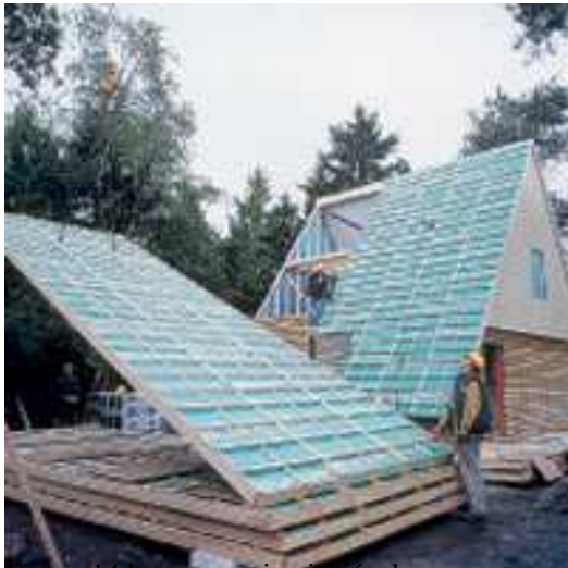
Figuur 14 kapvervanging in één dag
