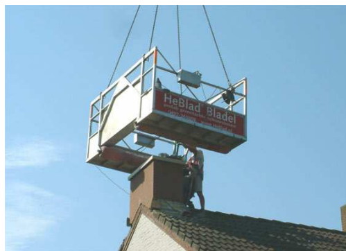
Figuur 18 aanbrengen van een prefab schoorsteen
