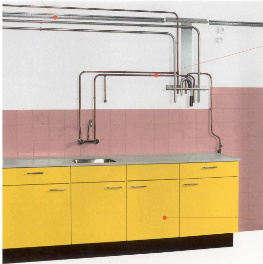
Figuur 24 keuken als verbeterunit, keuken en verwarming geïntegreerd
