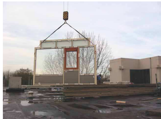
Figuur 13 Twin-vliesgevel als pui monteren
