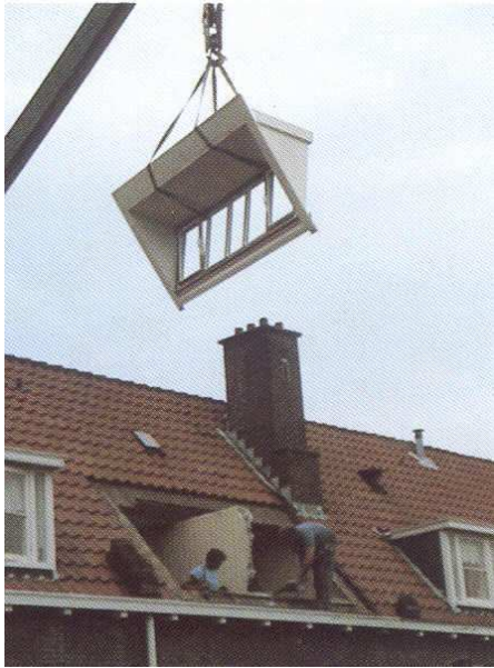
Figuur 15 Volledige geprefabriceerde dakkapel
