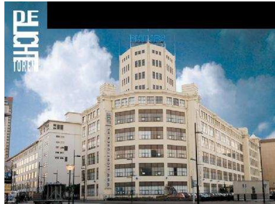
Figuur 2 Bestaande industriële gebouwen in een nieuw jasje gestoken
