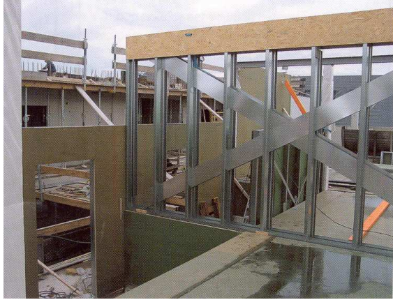
Figuur 10 Staalframebouwelement met kruisverband
