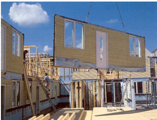
Figuur 22 Gevels prefabriceren
