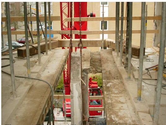
Figuur 6 Zagen en hijsen in plaats van breken en storten zijn de gebruikte technieken
